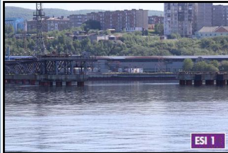
Искусственные конструкции и портовые сооружения
